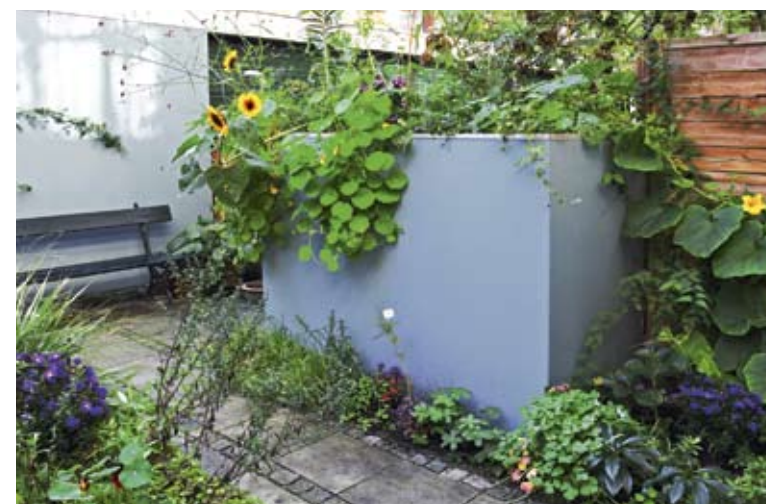
Bergruimte en 'plantenbak' ineen. De 1,3 m hoge kast staat 20 cm diep in de grond zodat er twee fietsen in passen, de bovenste 15 cm wordt ingenomen door een laag teelaarde waarin planten kunnen groeien. De aluminium strips voorkomen dat het hout gaat rotten. De schutting stond er al, klimplanten moeten ervoor zorgen dat die snel aan het oog onttrokken wordt.
